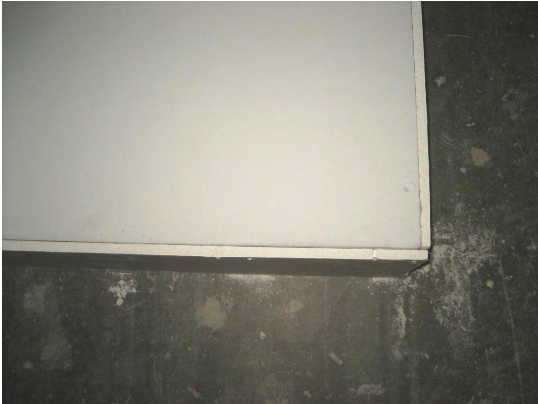
Bild 3: Asona Sonacoustic G, mit Asona Sonaplaster G, Dicke 1 mm, Detail
